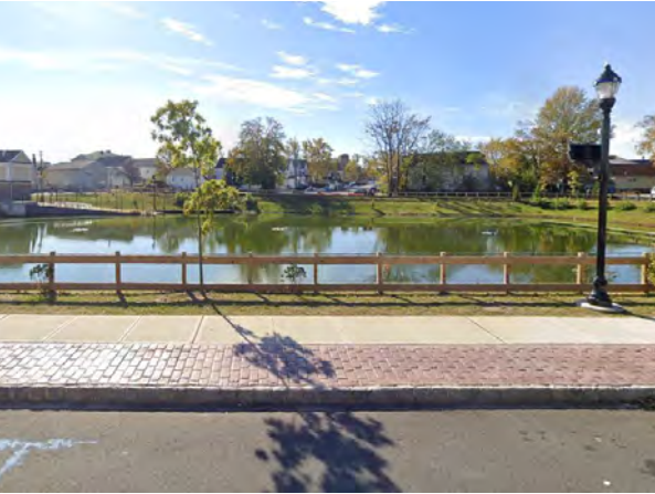
ESTANQUE DE RETENCIÓN DEL PARQUE NOE’S CREEK Carteret, NJ
