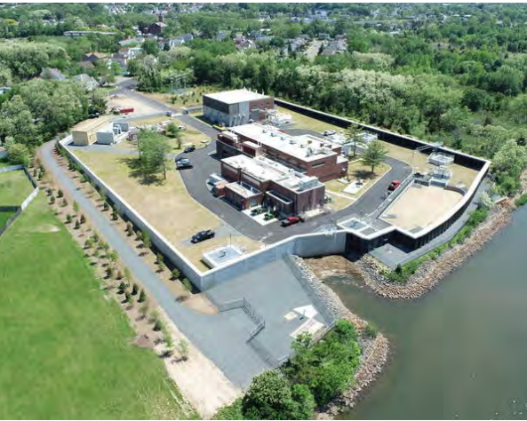
ESTACIÓN DE BOMBEO DE SAYREVILLE Sayreville, NJ
