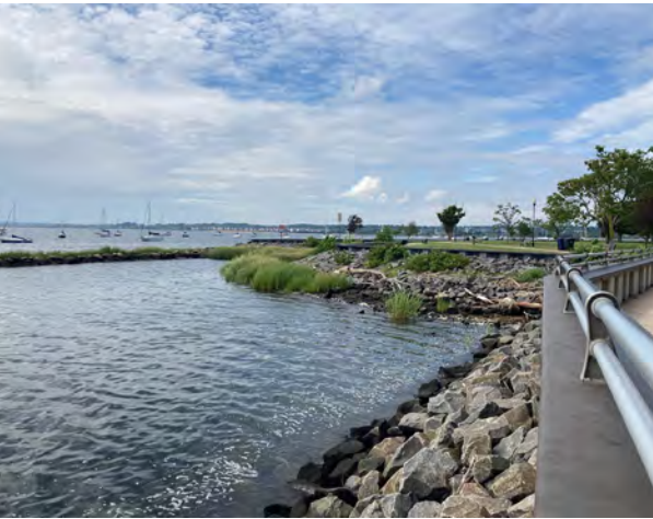
REPARACIÓN DE MAMPAROS FRENTE AL MAR Perth Amboy, NJ
